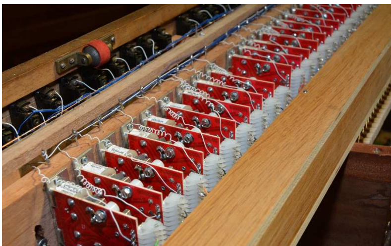
Moteurs à double bobines à l'arrière des registres
